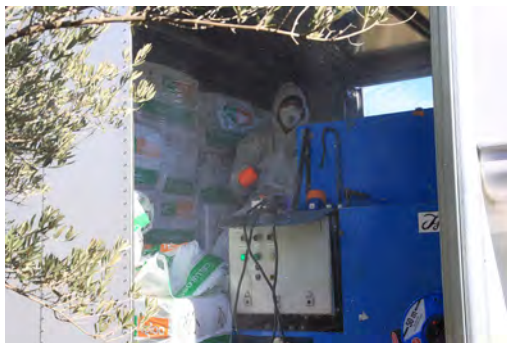
Janvier 2014 : Isolation de la charpente (flocage par des martiens).
