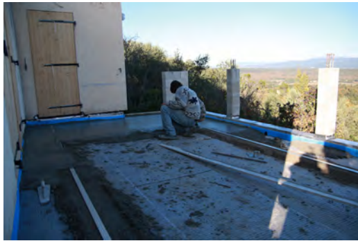
Avril 2014 : chape de la terrasse du bas.
